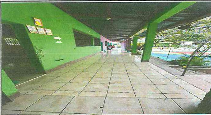
Foto 1: Terminado colocación de piso cerámico.
