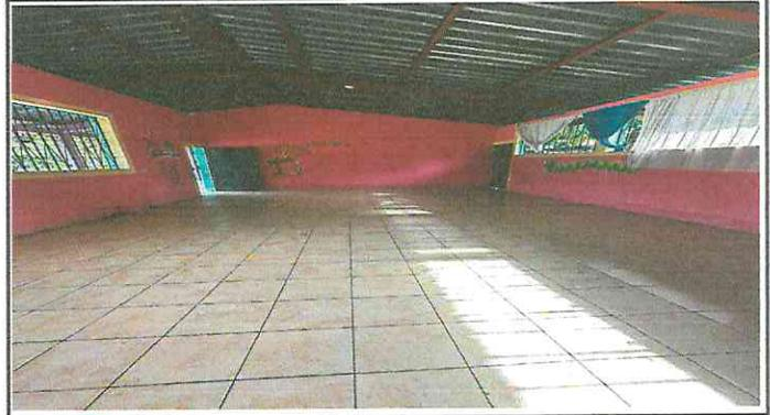
Foto 2: Terminado colocación de piso cerámico.
